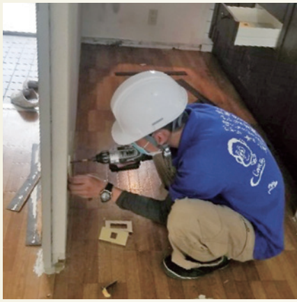
アパートのリフォーム作業(実習時)
